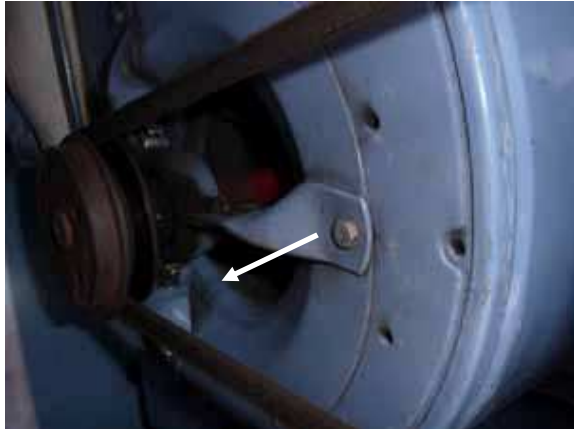
Abb. 9: Verschmutzung durch Keilriemenantrieb
