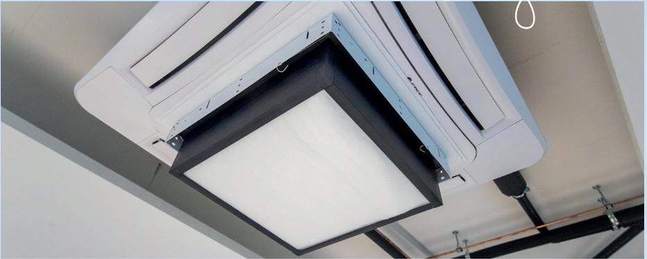
In Zeiten der Pandemie kommt der Hygiene eine ganz besonders bedeutsame Rolle zu. Durch die Filterung der Luft kann im Raum, zusätzlich zu den periodisch durchgeführten Wischdesinfektionen, die Infektionskette unterbrochen und die Verteilung der Keime im Raum kann verhindert werden.
